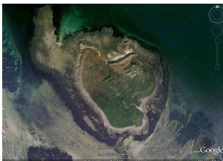
Vue aérienne de l'île Cézon et de son fort, GoogleEarth, 28/07/2010
